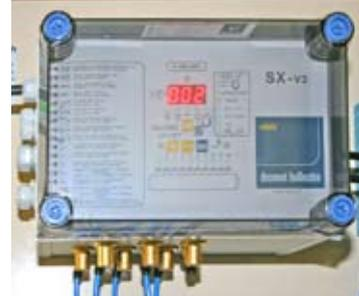
Notre séquenceur permet la commande et le contrôle de décolmatage des filtres à poches et à manches.
