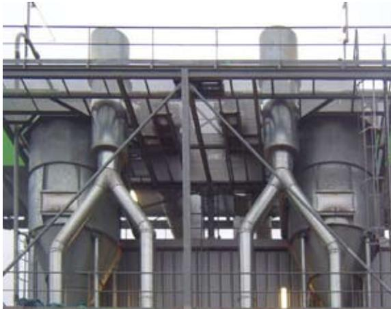
Filtres à manches avec vannes de découplage et membrane d'explosion
