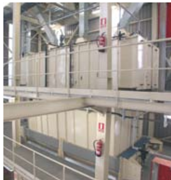
Refroidisseur alimenté par 3 presses
