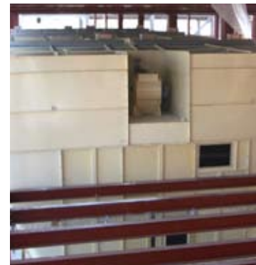
Refroidisseurs avec filtres encastrés
