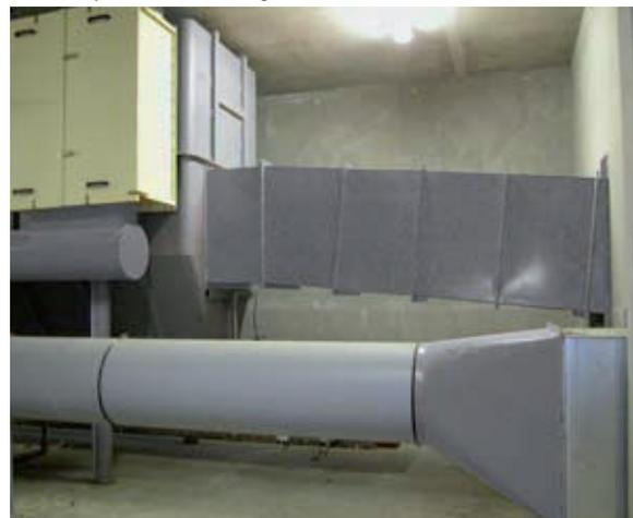
Panel de explosión y conducto de evacuación al exterior
