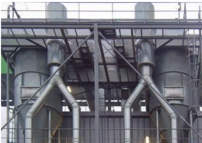
Filtro de manga con válvulas de aislamiento y panel de explosión
